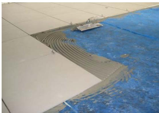
Fig. 4: posa pavimentazione
