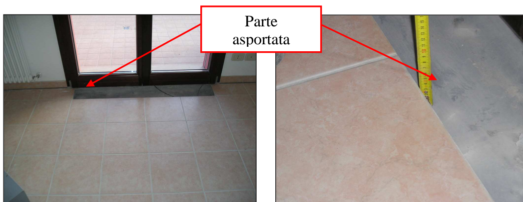
Fig. 4 – Particolare del pavimento con massetto asportato
