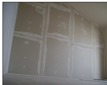
Fig. 18 – Vista controparete (una lastra di cartongesso)
