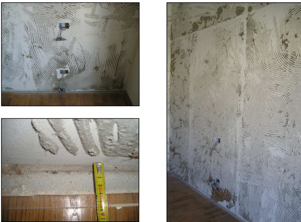
Fig. 15 – Vista parete dopo la rimozione del contro-placcaggio
