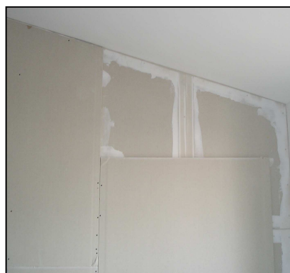
Fig. 18 – Vista controparete (due lastre di cartongesso)
